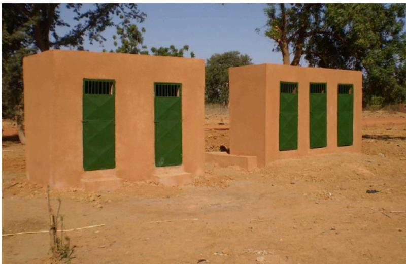
*Latrines de Zitenga, servant de modèle de base, avec douches séparées, permettant l'évacuation de l'eau directement dans les strates des sous-sols.*
